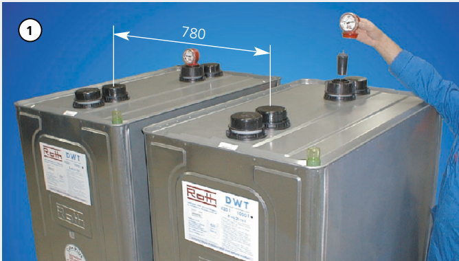
Tanks auf Fußgestell aufsetzen und im Tank-Mittenabstand von 780 mm nebeneinander aufstellen; Füllstanduhren in Gewindebuchsen auf dem 3. Tankstutzen einschrauben
