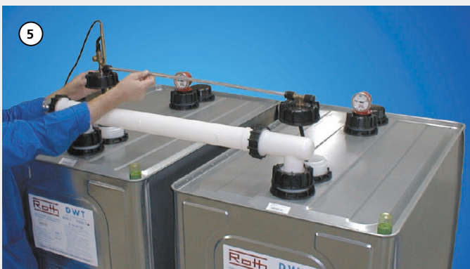
Entnahmeleitung auf 2. Tankstutzen aufsetzen; dabei Sammelarmatur mit GWG auf 1. Tank in Füllrichtung montieren; Grenzwertgeber nach Tabelle einstellen
